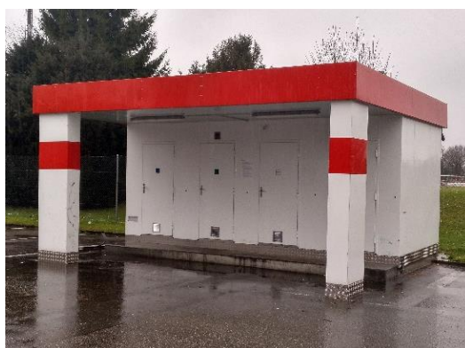
Container mit Toiletten-/Duschanlagen
