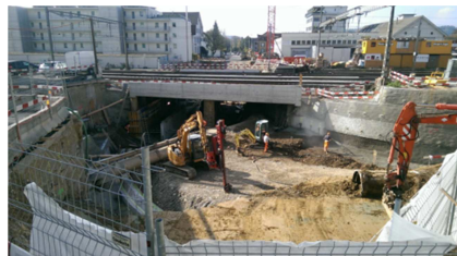
UF Strengelbacherstrasse Zofingen
